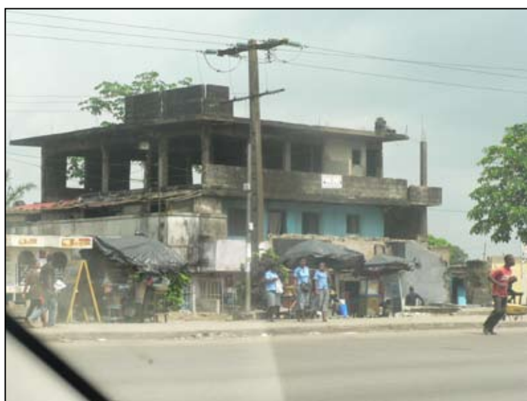
Bâtiment détruit lors des combats survenus à Abobo pendant la crise postélectorale
