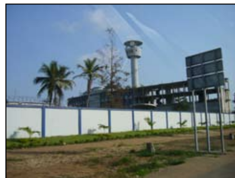
Le siège de la RTI, situé à Cocody (Abidjan)
