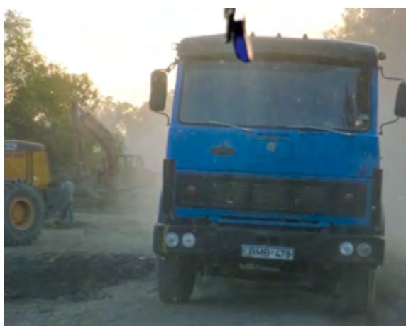
Multiplication des travaux d'infrastructures
