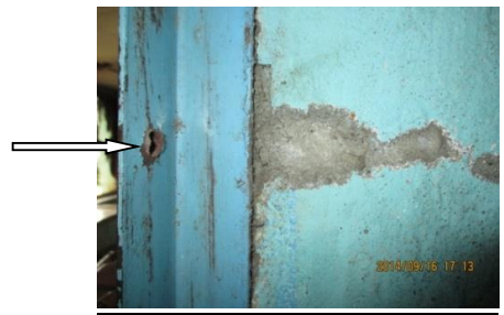
FIG 8 : L'ENCADREMENT DE LA PORTE MONTRANT LA MARQUE DE BALLE, 19, composé de défauts de perforation à travers le métal de l'encadrement avec des bords métalliques retournées vers l'intérieur et de sillons à travers la peinture/le mortier ou mur adjacent.
