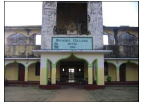
Ecole musulmane (Osmania College) en cours de rénovation à Jaffna
