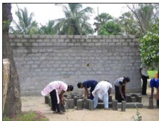
Femmes tamoules réinstallées dans le village de Palampiddy construisant une maison
