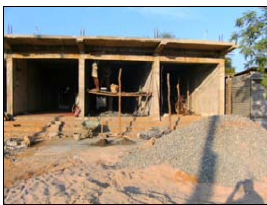
Construction de «compartiments chinois» pour des boutiques à Mullaitivu
