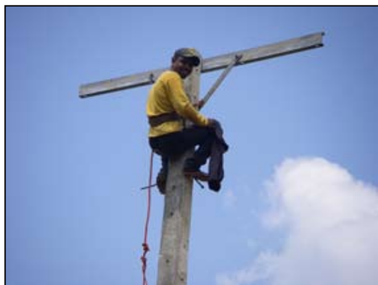
Rénovation du réseau d'électricité dans la région de Madhu, au sud-ouest du Vanni
