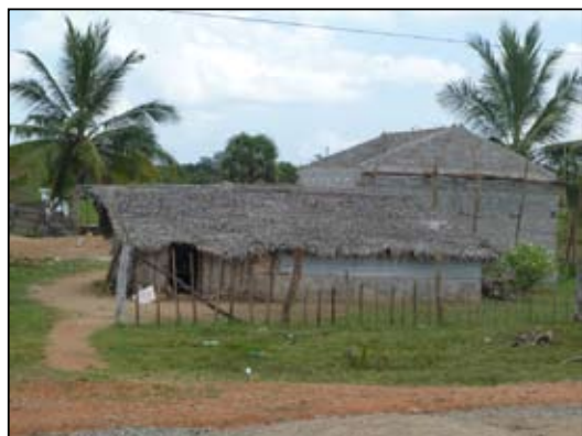
Reconstruction d'une maison et habitat temporaire dans le Vanni le long de la route A9
