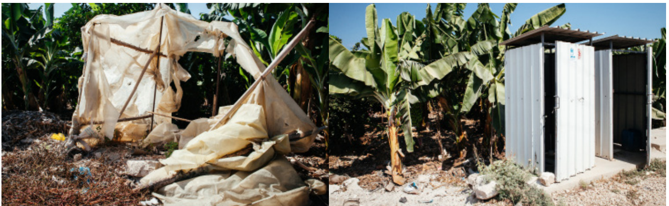
Avant et après: Une latrine primitive (à gauche) a été construite par des réfugiés à Aaddousiyyeh, au sud du Liban. Elle présentait des risques de protection importants, en particulier pour les femmes et les filles, ainsi que des préoccupations environnementales et sanitaires. En réponse, le HCR l'a remplacée par trois latrines standard (à droite) connectées à une fosse septique, apportant ainsi des améliorations notables au niveau de la santé et de la protection des familles concernées. © UNHCR/Martin Dudek
