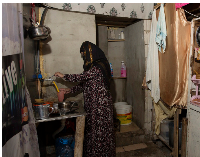
ห้องครัวซึ่งได้รับการติดตั้งอย่างง่ายและปรับปรุงท่อน้ำให้มีสุขลักษณะที่ดี
