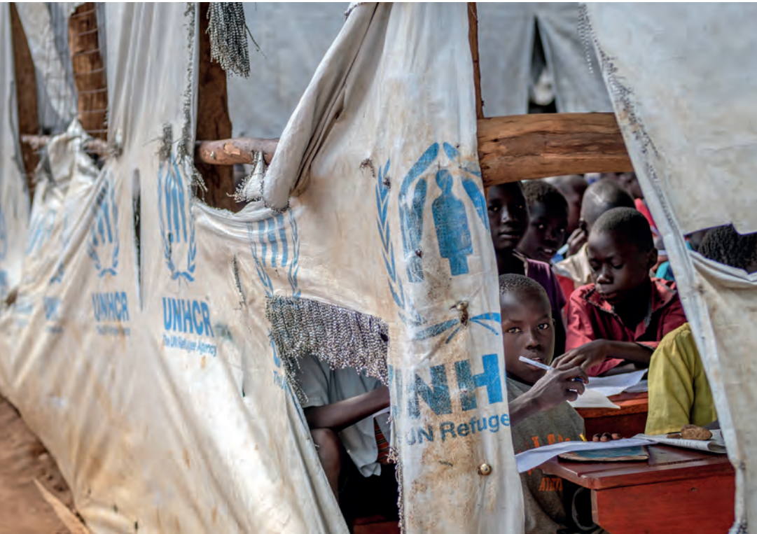
Une école temporaire, construite de bois et de bâches en plastique, fut endommagée au site Bidibidi au Nord de l'Ouganda suite à de fortes tempêtes. © UNHCR / JIRO OSE
