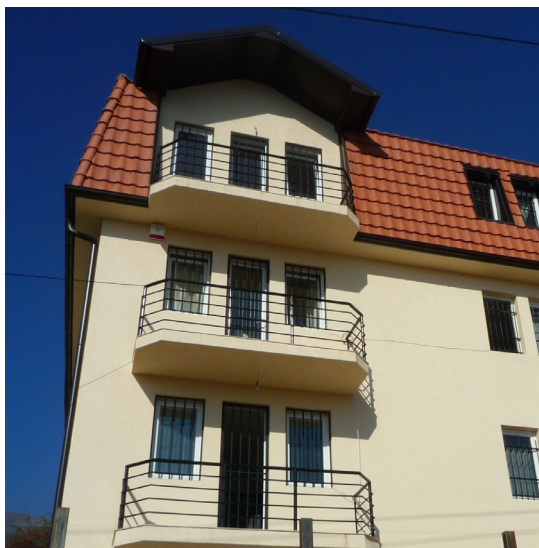
Locaux du Women Wellness Center, à Pejë/Peć
