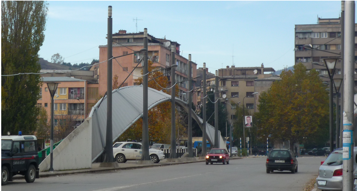
Pont principal de Mitrovica, vue de la rive nord de l'Ibar
