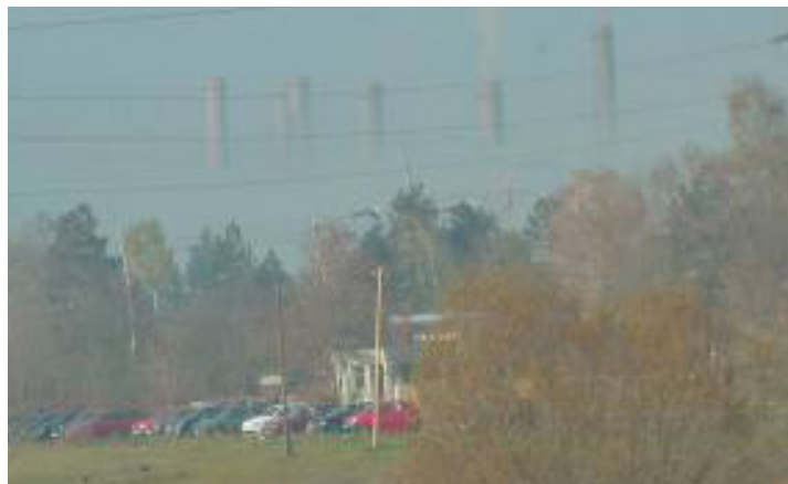
Centrale électrique d'Obiliq/Obilić
