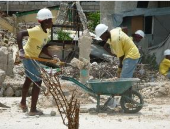
Ci-dessus : Travailleurs journaliers déblayant les gravats laissés par la catastrophe, juin 2010.
