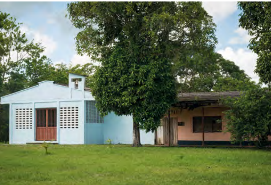
Así quedaron la iglesia y la casa cural luego de que la comunidad de Puerto Torres pintara las fachadas de las construcciones ubicadas alrededor del parque principal. Puerto Torres, Belén de los Andaquíes (Caquetá), 2017.
