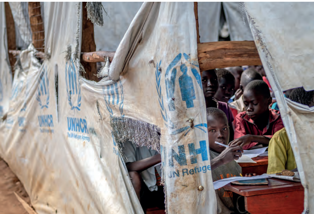
Una escuela primaria temporal, construida con palos de madera y lonas de plástico en el asentamiento de refugiados Bidibidi en la provincia de Yume en el Norte de Uganda ha sido dañada por fuertes tormentas. © UNHCR / JIRO OSE
