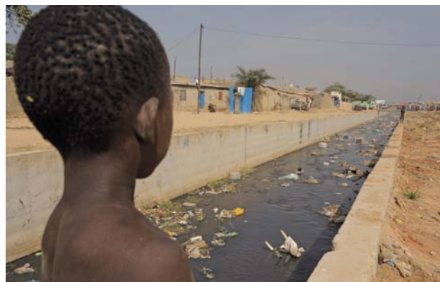
Un garçon regarde un caniveau jonché de déchets dans la banlieue de Luanda, en Angola. La région manque d'eau courante, d'infrastructures d'assainissement de base et de logements adaptés. Ce caniveau déborde à la saison des pluies.
