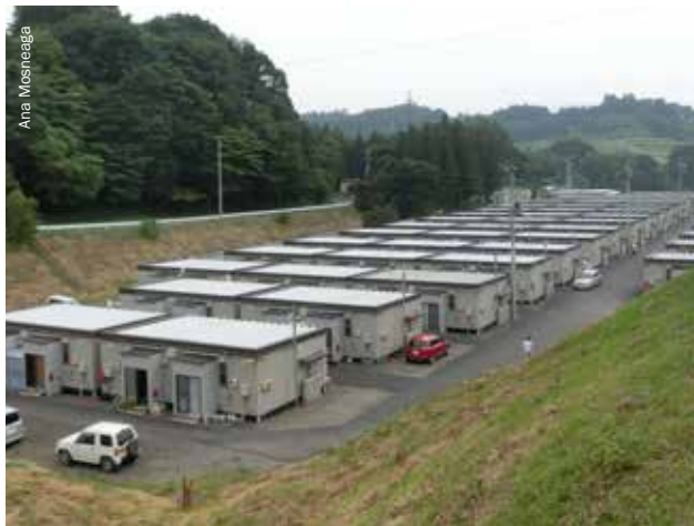
Viviendas temporales prefabricadas para los desplazados internos tras el desastre nuclear de 2011, prefectura de Fukushima, Japón.
