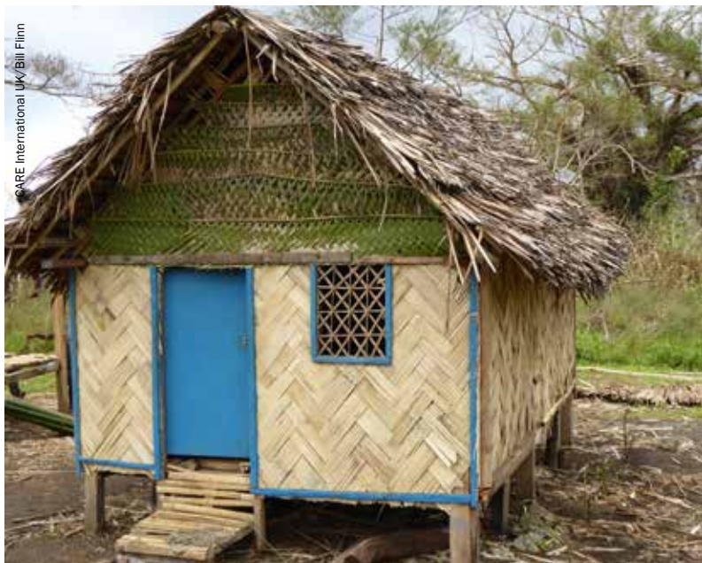
Autorecuperación en Vanuatu.
