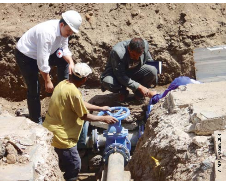
Un ingeniero del CICR y un miembro del organismo local de abastecimiento de agua conectan la principal tubería pública de agua para aprovisionar un distrito de la ciudad yemení de Saná. Diciembre de 2016.
