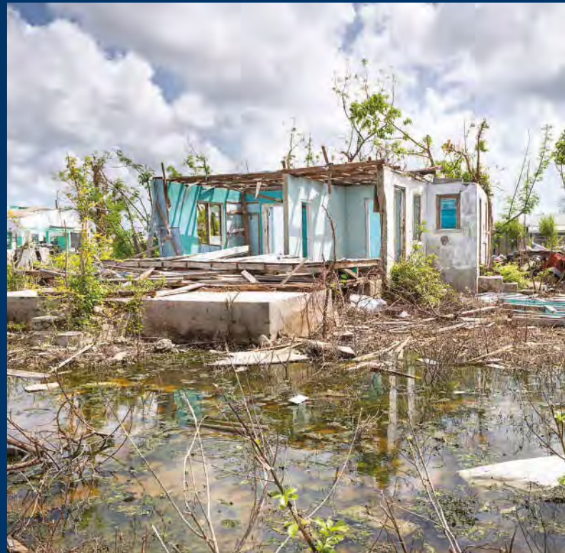
Daños provocados por el huracán Irma en Codrington, Barbuda Foto: ONU/Rick Bajornas
