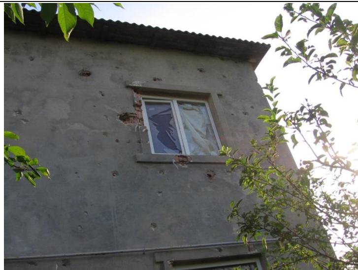
Осколки посекали стены, крышу, выбили стекла в этом доме и соседнем, № 2., пробили металлическую ограду и железные ворота, перелетев улицу, посекали крышу дома № 9.
