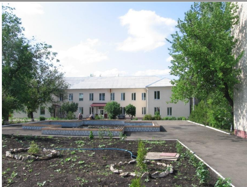
Новосветловка. Разрушенный в августе 2014 г. и восстановленный в 2016 г. корпус больницы.
