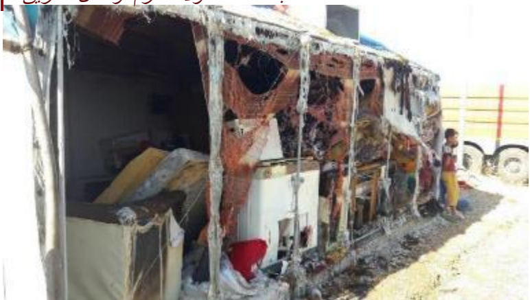
Mixed installed extensions and not respecting fire breaks ملحقات مثبتة مختلطة ولا تحترم فواصل الحريق
