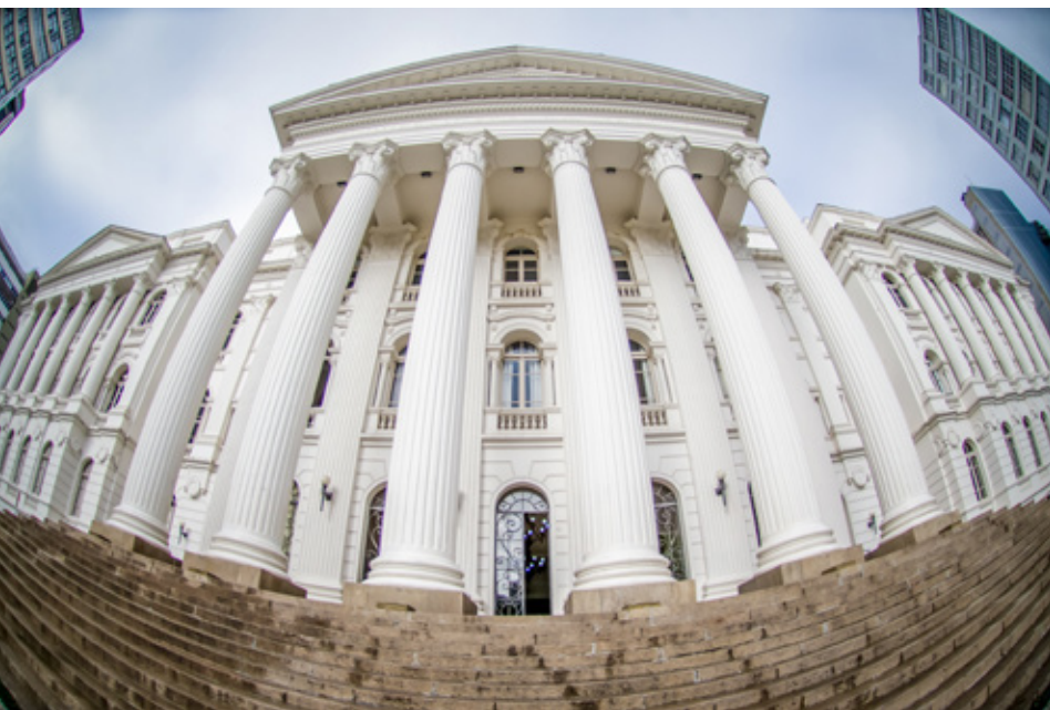
Fachada da Universidade Federal do Paraná, na Praça Santos Andrade. Fonte: Marcos Solivan
