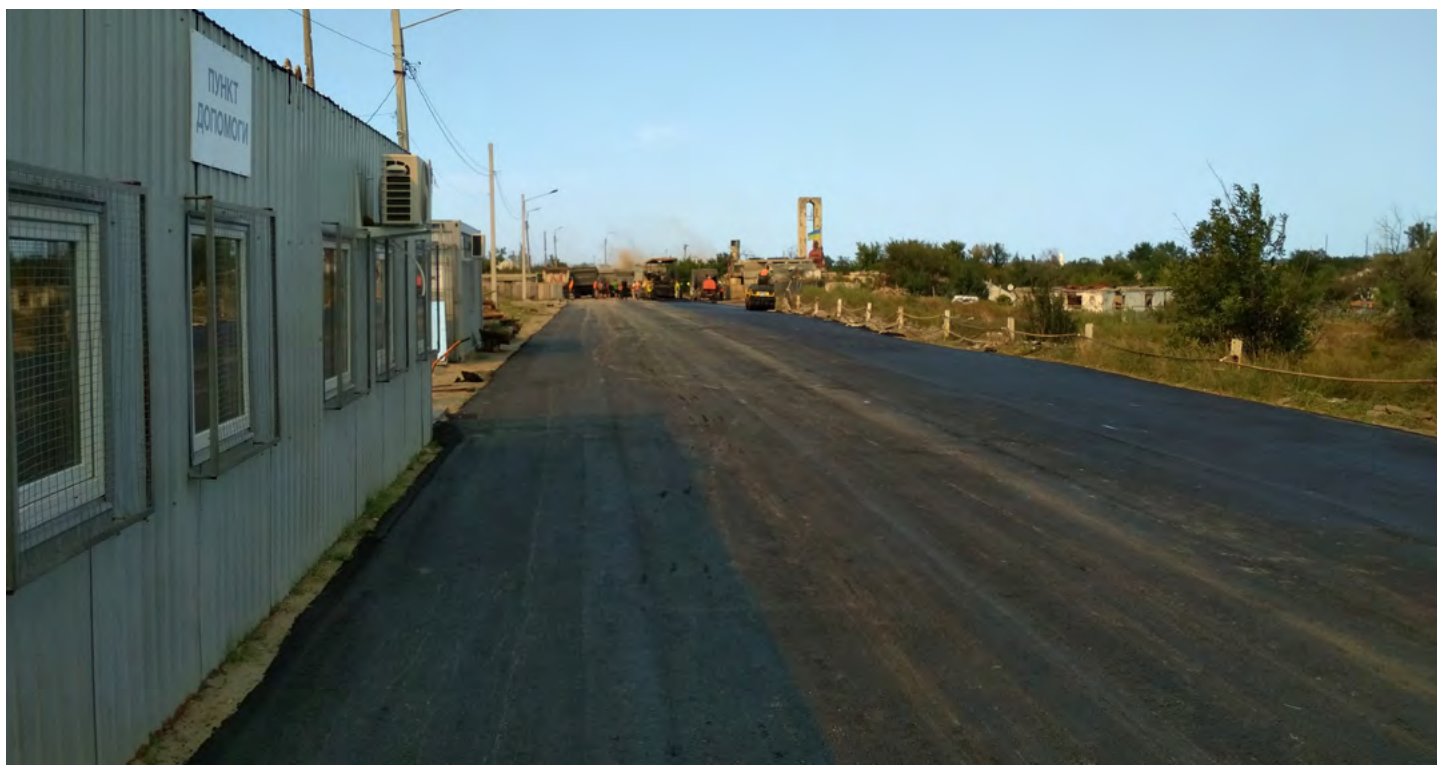
КПВВ «Станиця Луганська». Реконструкція, укладка асфальту
