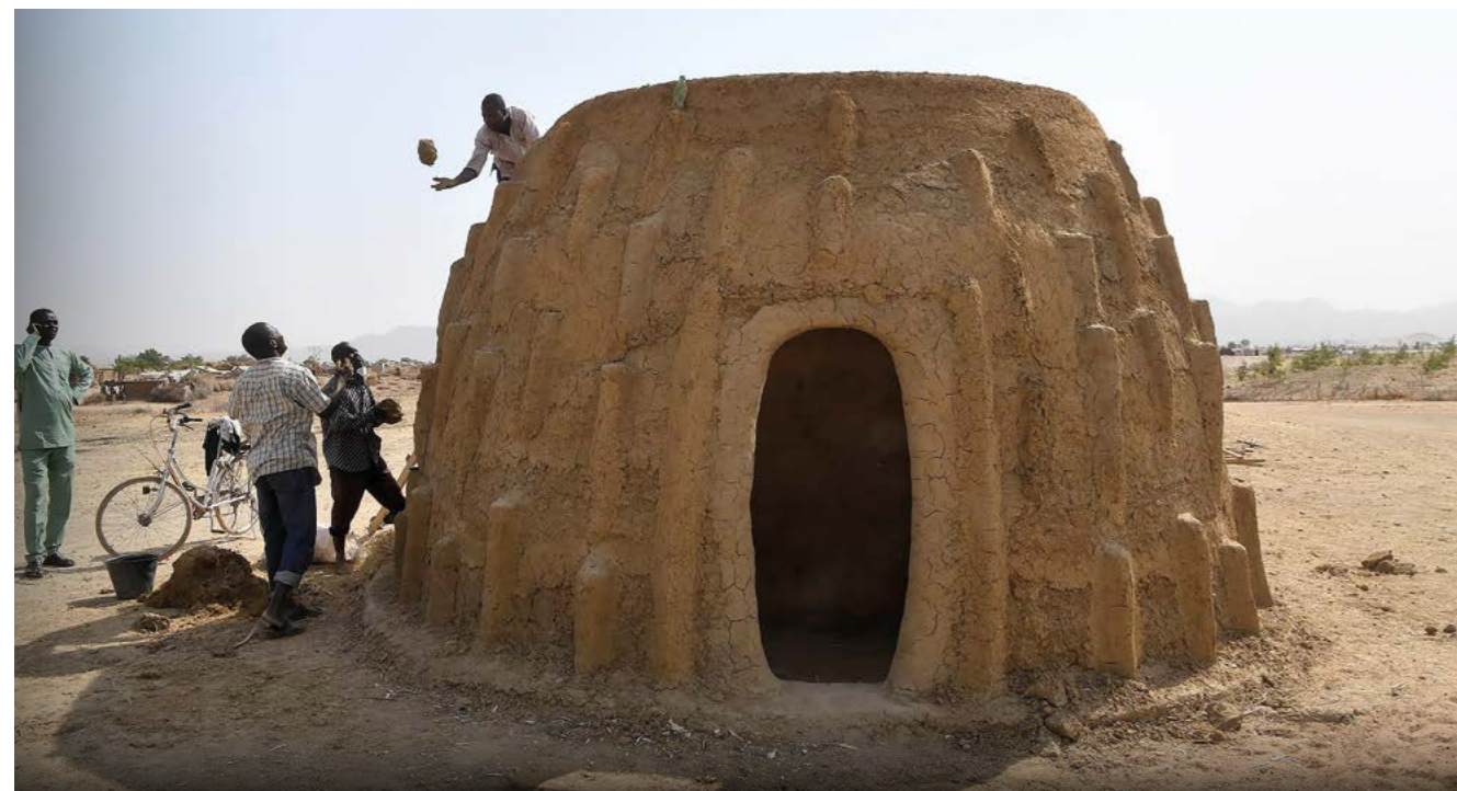
Un réfugié nigérian travaille à la construction d'une maison traditionnelle en terre séchée dans le camp de Minawao, au Cameroun. La maison est construite à titre d'essai et si l'expérience est concluante, d'autres maisons de ce type pourraient être construites afin de fournir des abris sans utiliser de bois.
