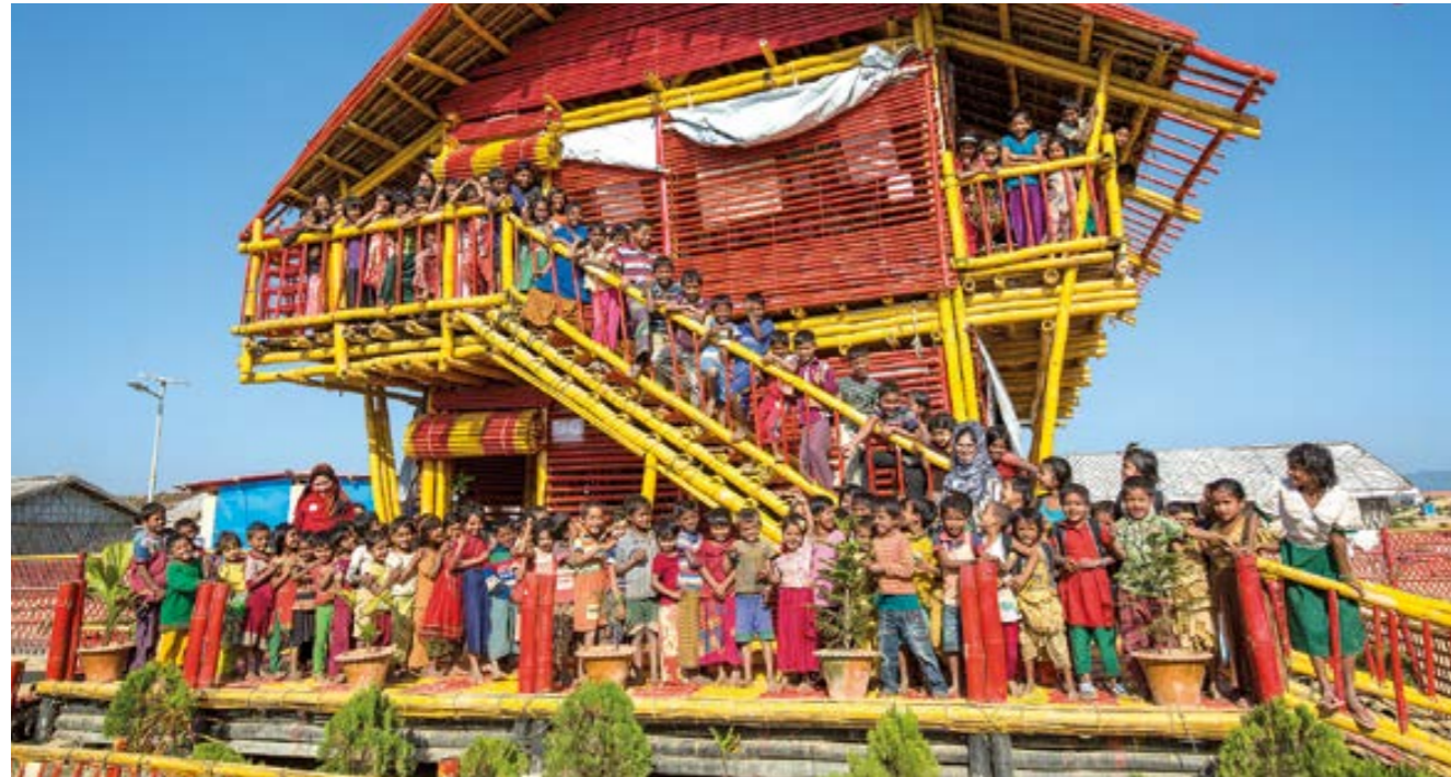
Le Centre d'apprentissage Sunflower dans l'extension du camp 4 de Kutupalong, au Bangladesh, est le premier bâtiment à deux étages dans le camp et il a été conçu pour gagner de l'espace et réduire la surpopulation.
