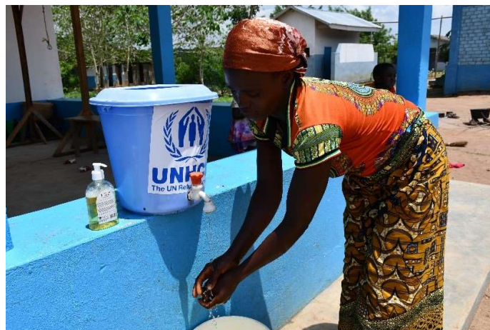
Une réfugiée de République Centrafricaine se lave les mains au camp de Inke, Province du Nord Ubangi Province, grâce à une station de lavage de mains installée par le HCR pour répondre à la pandémie de COVID-19. © UNHCR/Ghislaine Nentobo
