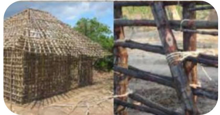
Reconstrução na região de Nampula (2012) – 2000$/casa (mão-de-obra inc.) © UN – Habitat
