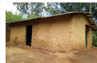
Enduit en terre, Katoto, Ituri
