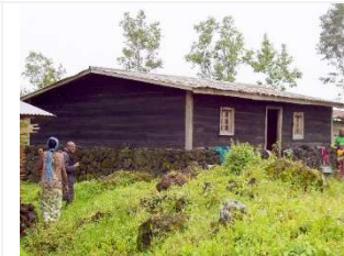
Maison avec bardage en bois près de Goma, Nord-Kivu
