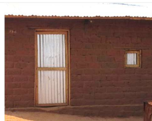
Porte et fenêtre en tôle avec encadrement en bois à Sango Malumbi, Tanganyika
