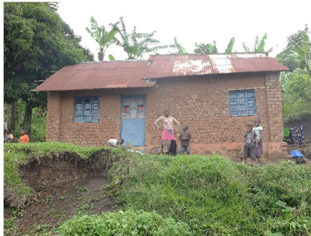
Maison en adobe Nord Kivu _ Goma_Chefferie Bahunde_Groupement Bweremana
