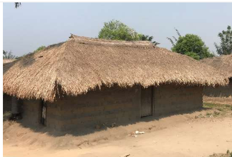
Couverture en paille à Taba, Tanganyika
