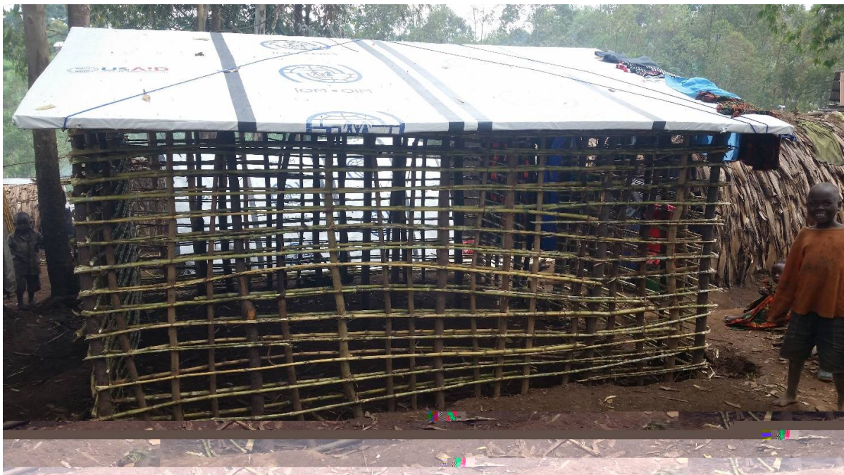
Abri en construction par OIM au site de Rushashi, Nord-Kivu, ©IOM/Delphin SH., 2019
