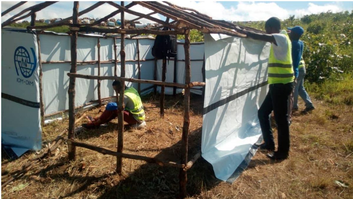
Abri construit par OIM au site de Kalunga, Tanganyika, ©IOM/W.Mwamini, 2019
