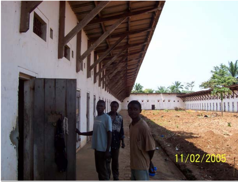
Le centre de détention de Osio en cours de réhabilitation
