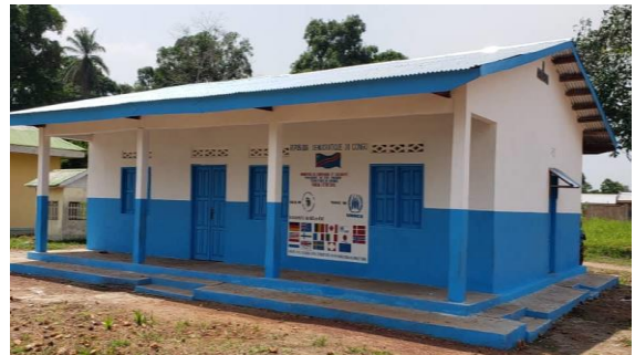
Nouveau Bureau d'Enregistrement construit par le HCR à Libenge, Sud Ubangi. © UNHCR/Ghislaine Nentobo
