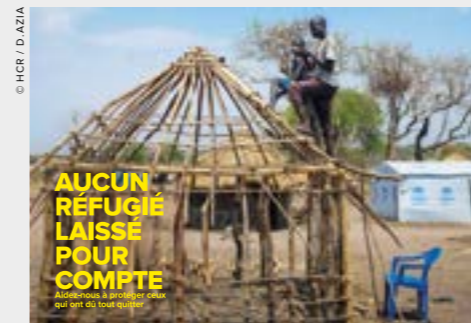
Les réfugiés sud-soudanais, Samuel, 16 ans, déplacé de Lainya, et James, 17 ans, déplacé de Wonduruba, travaillent sur le toit de chaume d'un abri de style tukul dans le site d'installation pour réfugiés de Bidibidi, située dans le district de Yumbe, au nord de l'Ouganda.
