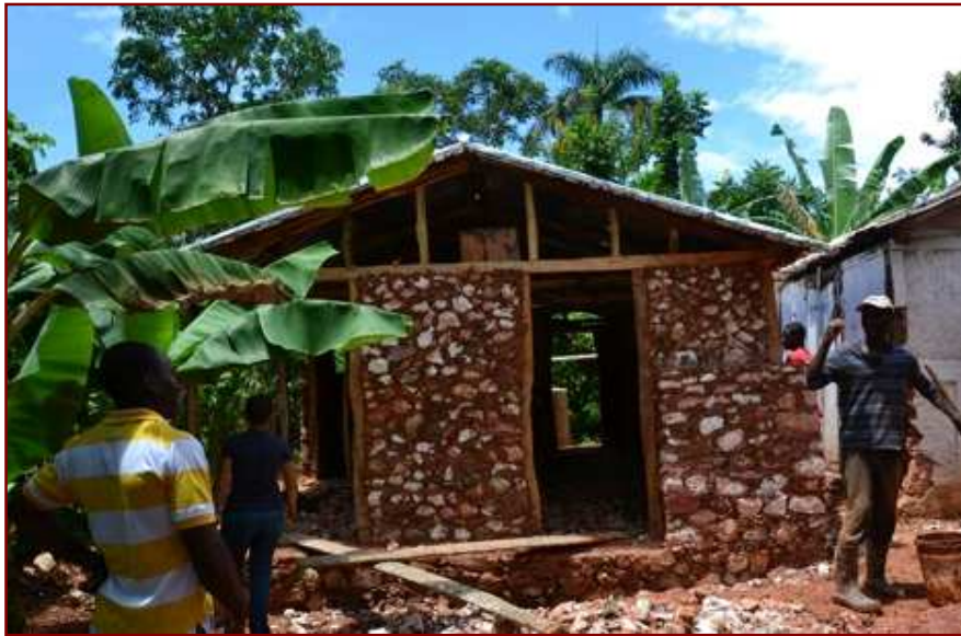
Maison neuve en structure bois (essences locales) et en remplissage de pierres. Grâce aux formations de CRAterre, cette maison intègre des améliorations para-sinistres (contreventements)
