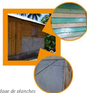
Bardage de planches peintes + maçonnerie de pierre et enduit ciment
