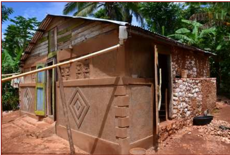
Cette maison montre le type de réparations réalisées par l'organisation. Les réparations concernent la structure porteuse et la toiture. Les finitions (enduits, peinture) n'ont pas pu être réalisées dans la limite du budget.
