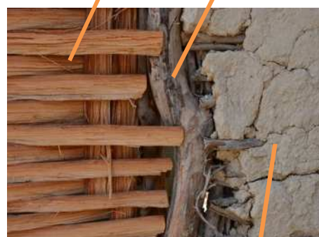
Clissage + mortier et enduit à la chaux
