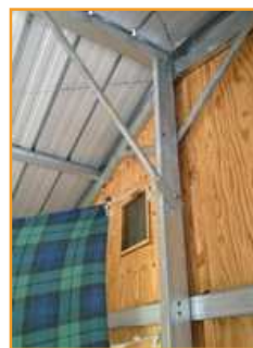
Structure en métal galvanisé et extrait du guide de maintenance Croix-Rouge Suisse, Léogâne
