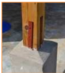
Accroche des poteaux de la galerie produite par l'artisan local
