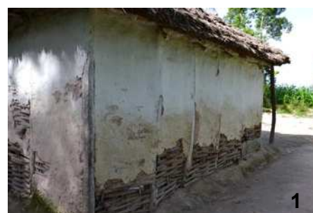
Clissage + mortier et enduit à la chaux
