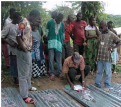
住居修復資機材の配布 写真提供：ピース ウィンズ・ジャパン
