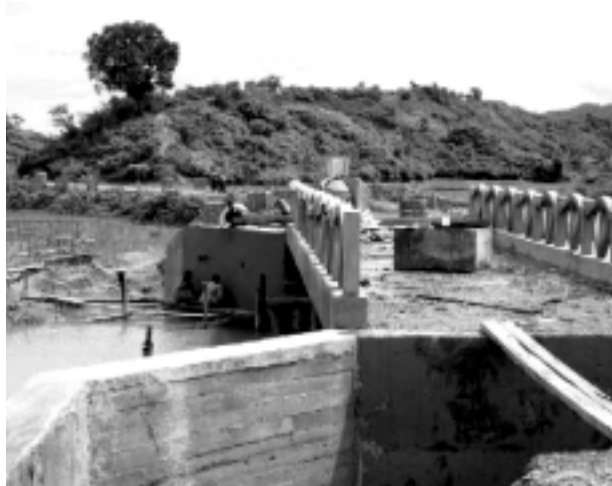
マウンドー北部でのBAJによる橋の建設 UNHCR
