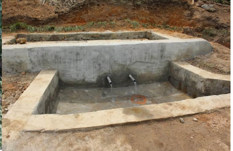
Source de Dankobéla aménagée
