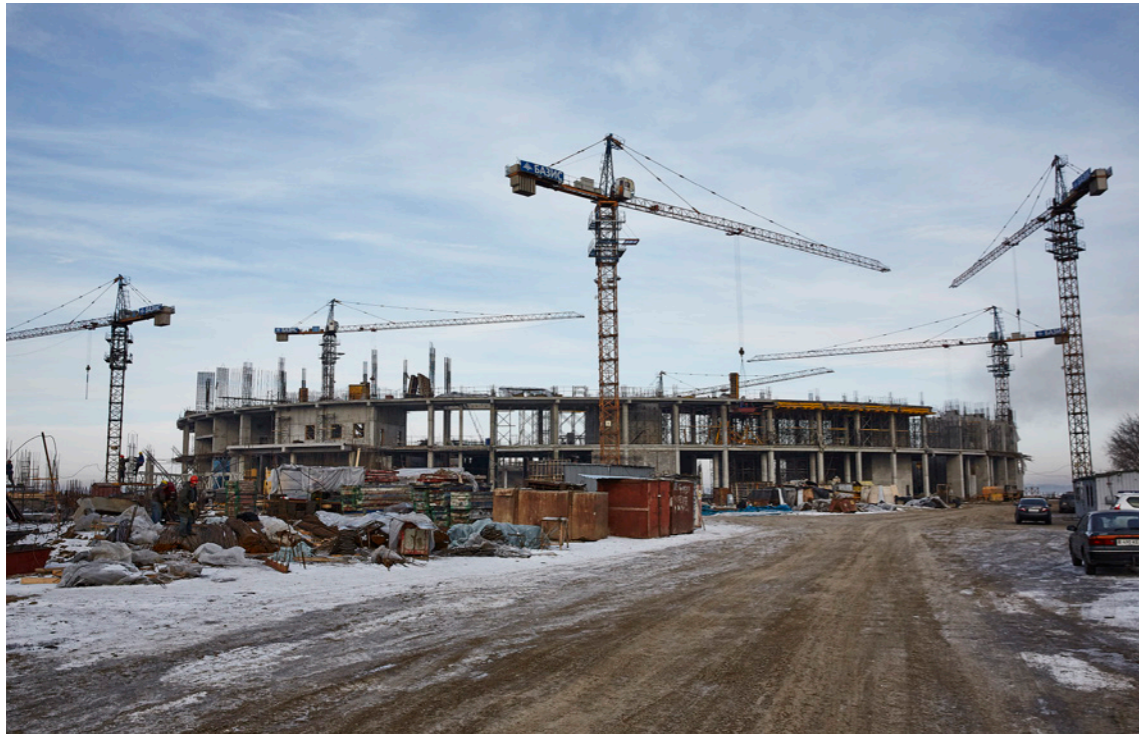
Palais de glace, site indépendant, hockey sur glace 1, en construction
