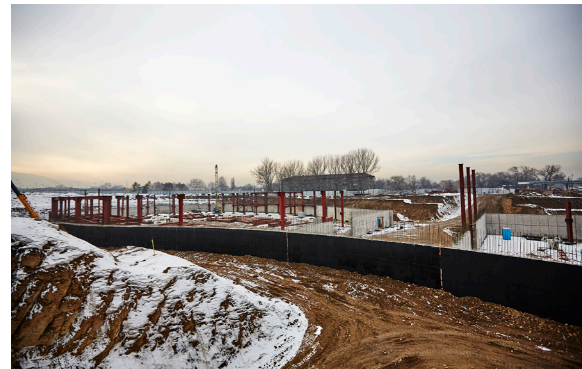
Complexe de curling, site indépendant, curling, en construction
