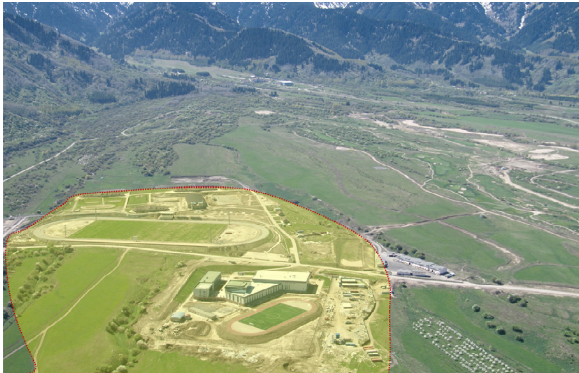
Ak Bulak, noyau Ak Bulak, village olympique, à construire
