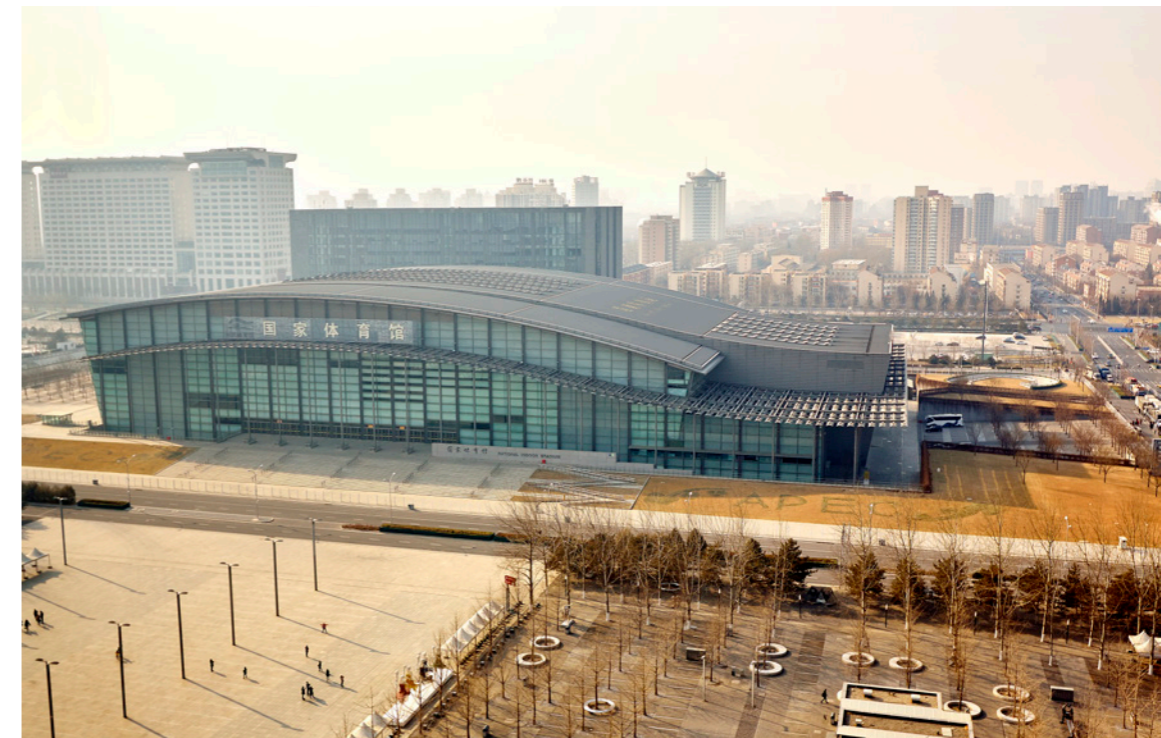
Stade intérieur national, zone du Parc olympique de Beijing, hockey sur glace 1, existant
