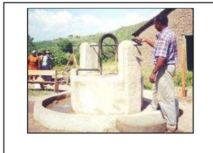
Puits protégé creusé à la main avec pompe manuelle
